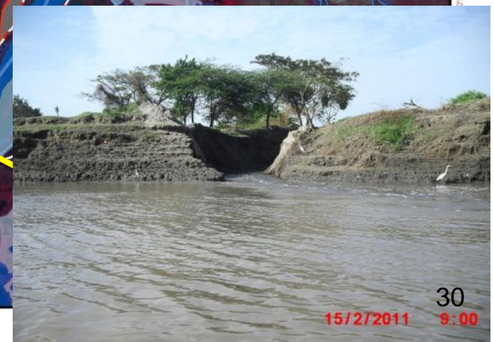
Ancho aproximado: 10 m. Caudal aproximado: 10 m 3 /s Margen izquierda del Canal del Dique. Departamento de Bolívar. Drenaje de la ciénaga de Jobo.
