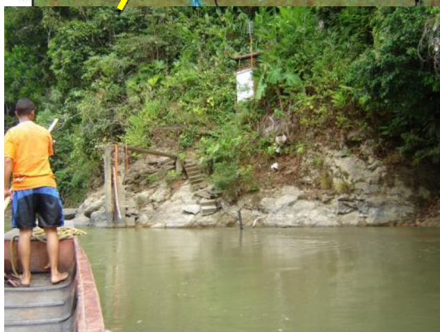
Sector Las Camelias del río Taraza, cota de inundación sobrepasó la estructura de la estación (Limnigráfica)
